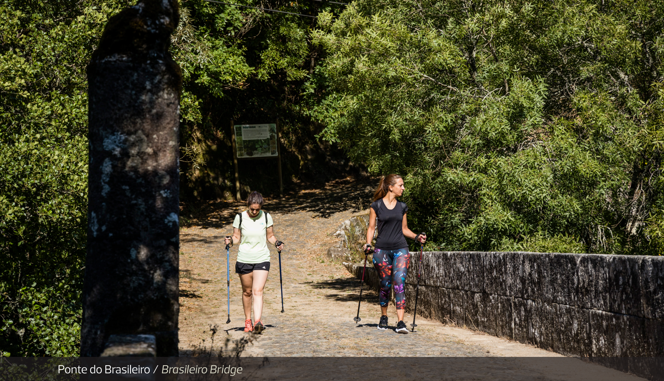
Ponte do Brasileiro / Brasileiro Bridge
